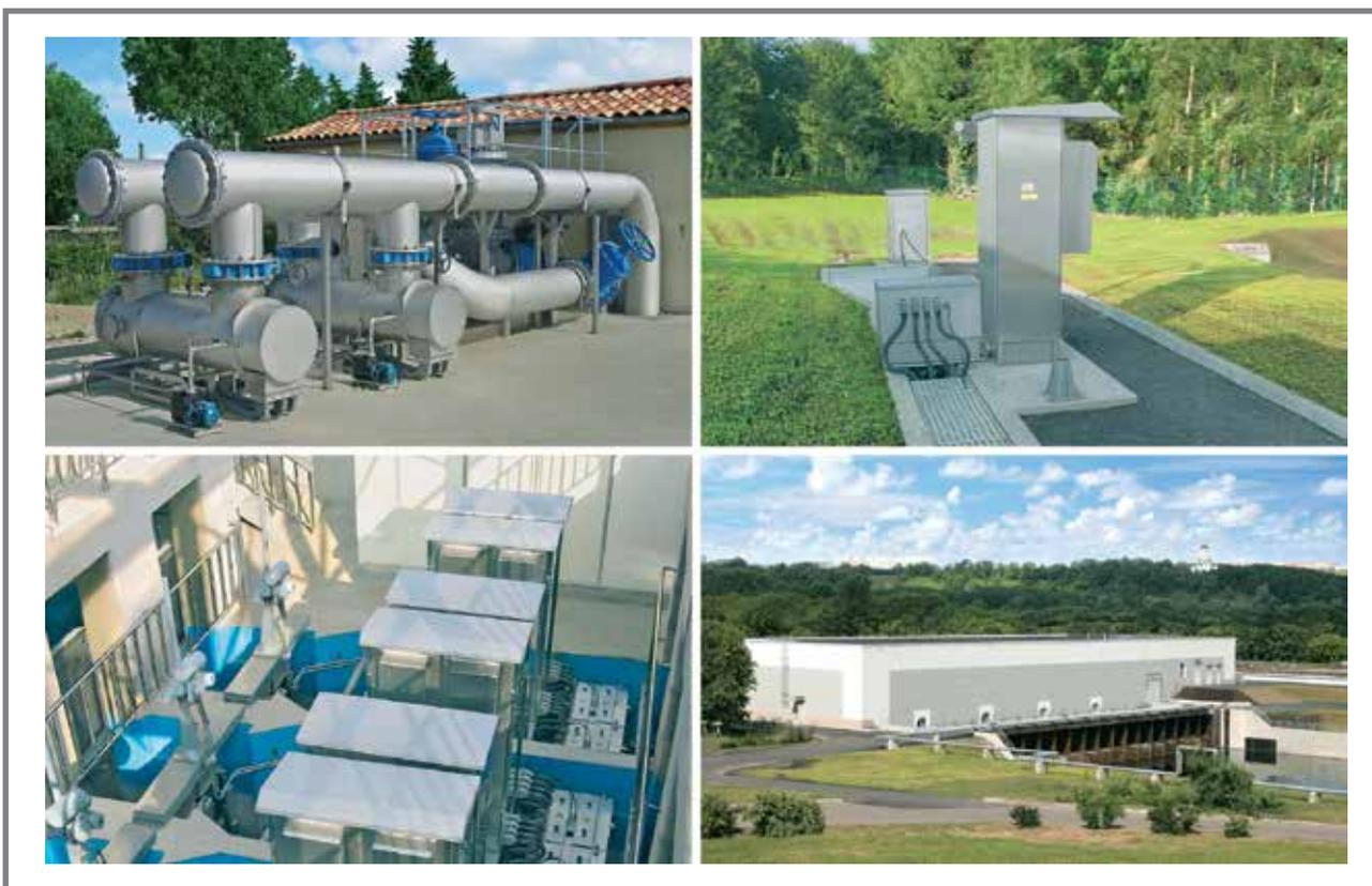
Сегодня особую актуальность приобретает применение современных установок для УФ-обеззараживания воды с использованием высокоомощных амальгамных УФ-ламп (мощностью от 300 до 900 Вт) длиной до 2,5 м, которые позволяют обеспечивать высокие УФ-дозы.
