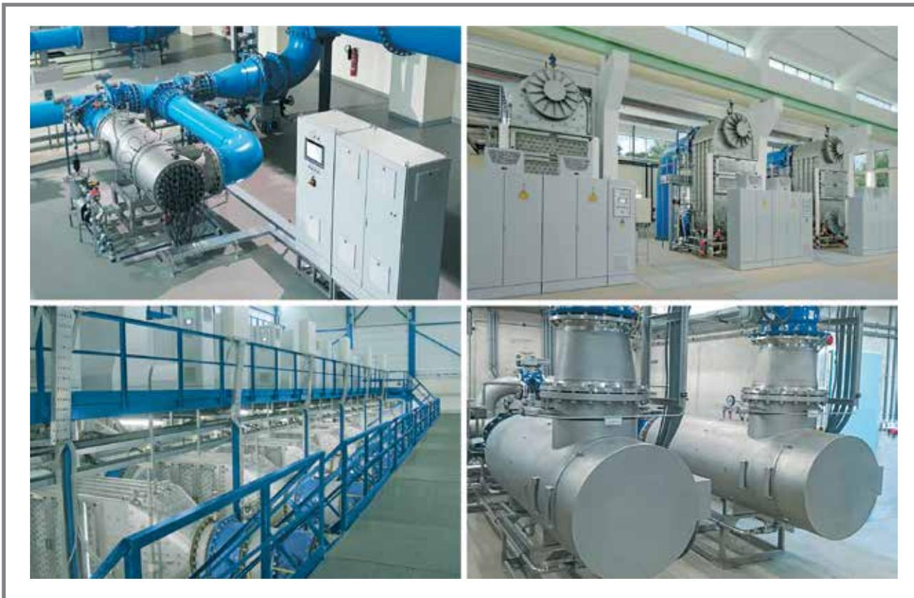
**Рисунок 2. Примеры УФ-обеззараживания сточных вод: г. Оранж (Франция), г. Шатоле (Франция), г. Гуми (Южная Корея), Москва (Россия)**
